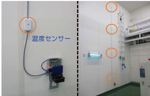
《壁面の温度センサー》
